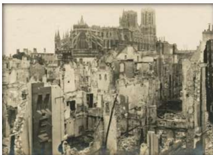
De haut en bas : le parvis de la cathédrale de Reims éventré par les obus et la toiture détruite
